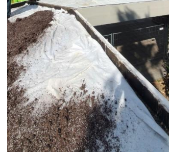
Definizione dei cordoli di contenimento e posa in opera della guaina antiradice
