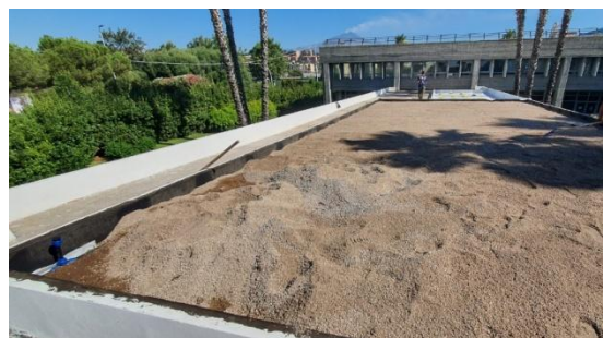
Definizione dei cordoli di contenimento e posa in opera della guaina antiradice
