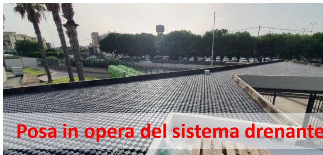
Definizione dei cordoli di contenimento e posa in opera della guaina antiradice
