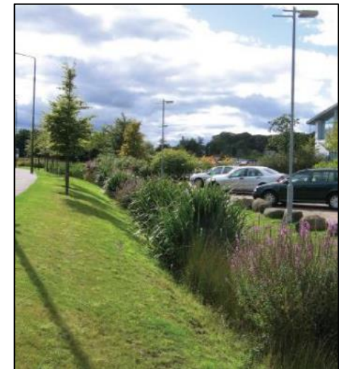
Esempio canale vegetato (Swale). Fonte: Woods Ballard et al. 2015. «The SuDS Manual»
