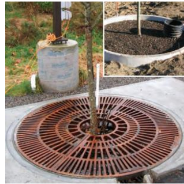
Particolare costruttivo box alberati filtranti (Tree Box Filter) e pavimentazione permeabile (Permeable Surfaces)
