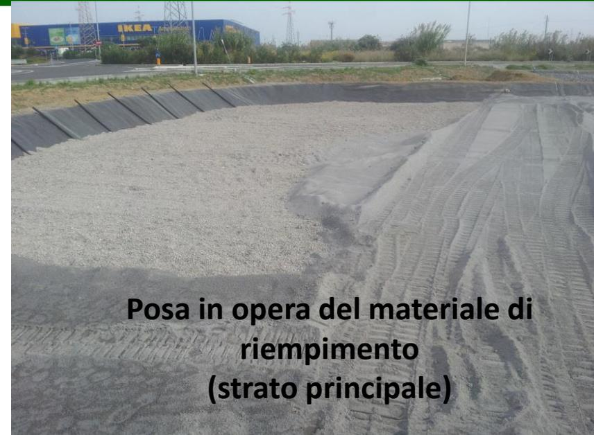
Posa in opera del materiale di riempimento (strato principale)
